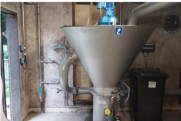
Die Leistungsfähigkeit der mechanischen Reinigung wurde dadurch von etwa 45 l/s auf 185 l/s erhöht. Zusätzlich ist die neue Anlage SPS-gesteuert und damit deutlich besser automatisiert und überwacht, manuelle Arbeiten und Kontrollen sind auf ein Minimum reduziert.
