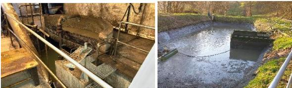
Die vorhandenen Maschinenteknik wurde durch einen Hakenumlaufrechen mit integrierter Waschgutpresse sowie einen Sandwäscher samt neuer Sandhebepumpe ersetzt. Im Zuge dieser Arbeiten wurden das vorhandene Zulaufgerinne sowie der Sandfang umgebaut und saniert. Zusätzlich wurde die Elektrotechnik in diesem Bereich vollständig erneuert und eine neue Schaltanlage installiert. Ergänzend wurden weitere Arbeiten im Bereich Brand- und Blitzschutz sowie der Brauchwasserversorgung durchgeführt.
